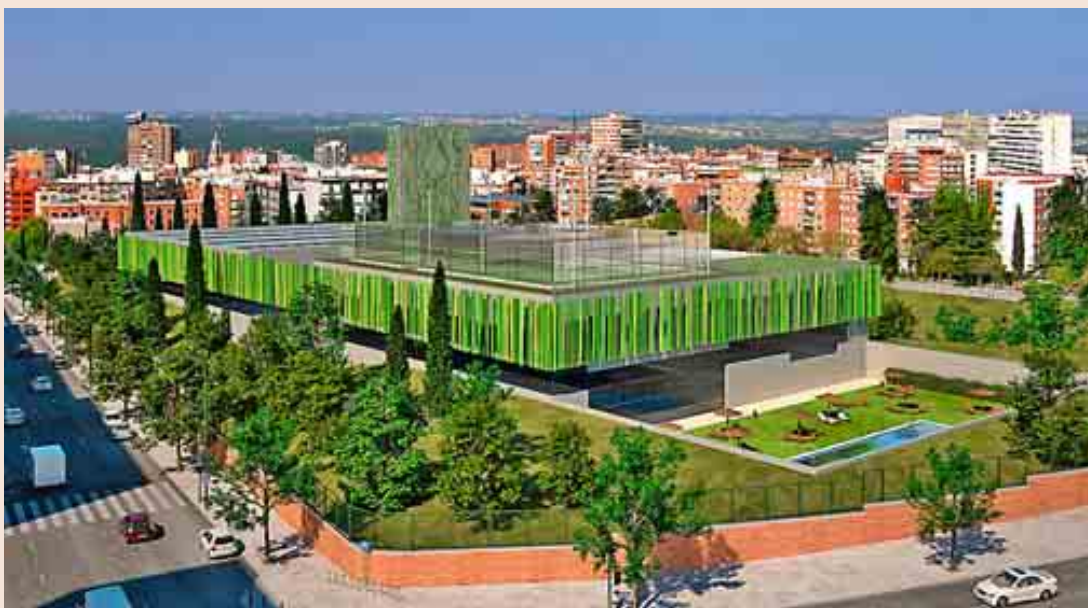
Recreación de cómo quedará la instalación situada en el centro de Madrid.
